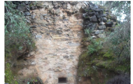
parte frontal do forno (local de carregamento de parte do forno e extração da cal)
